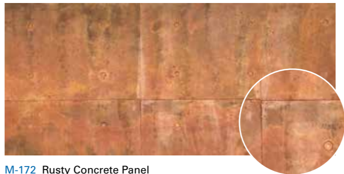
M-172 Rusty Concrete Panel Panel Cemento Encofrado Oxidado
